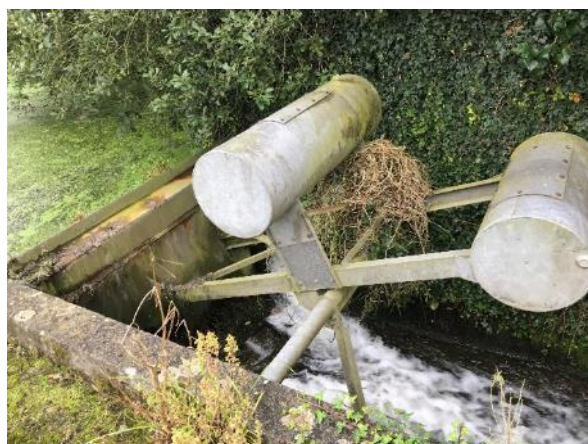
Vue de la passerelle en pierres plates placée devant le vannage – Vue de la vanne secteur à contrepoids.
