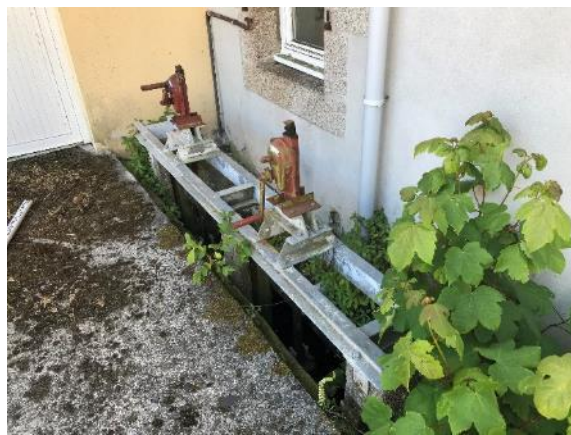
Vue depuis le lit amont du seuil de surverse en rive droite – Vue du vannage usinier devant l'entrée du moulin.
