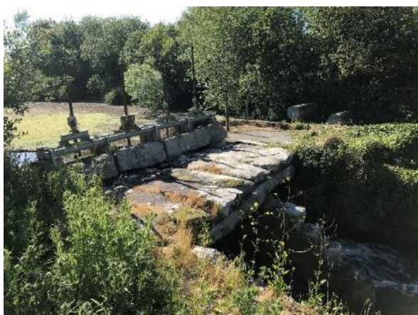
Vue de la passerelle en pierres plates placée devant le vannage – Vue de la vanne secteur à contrepoids.
