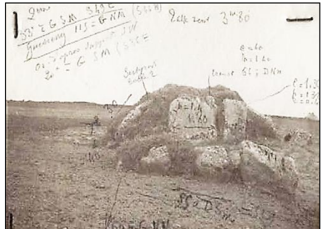
Vue de l'ouest.
